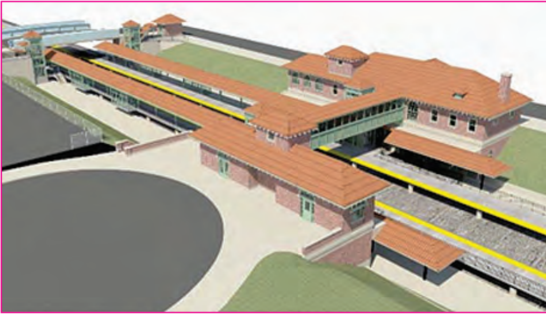
El proyecto de capital incluye nuevas plataformas de alto nivel, ascensores, escaleras y rampas, para que la estación sea completamente accesible.
