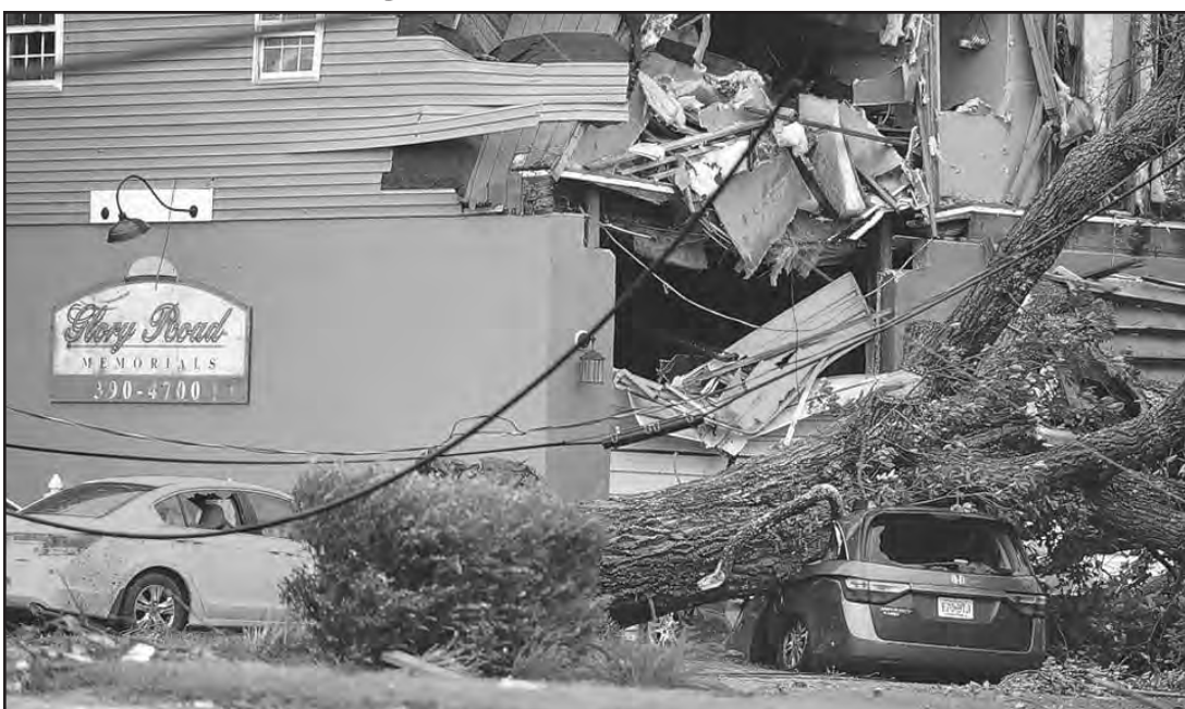
Las líneas eléctricas caídas, los generadores portátiles de gas y el envenenamiento por monóxido de carbono son una amenaza constante.
