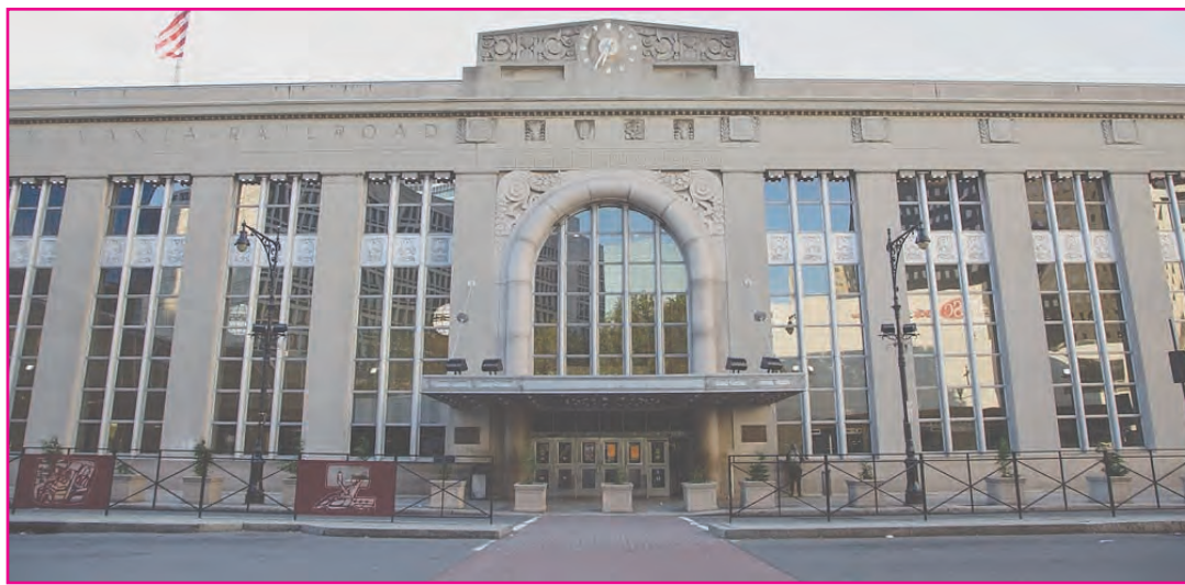
Gráfica de la actual estación Newark Penn Station que será completamente renovada.
