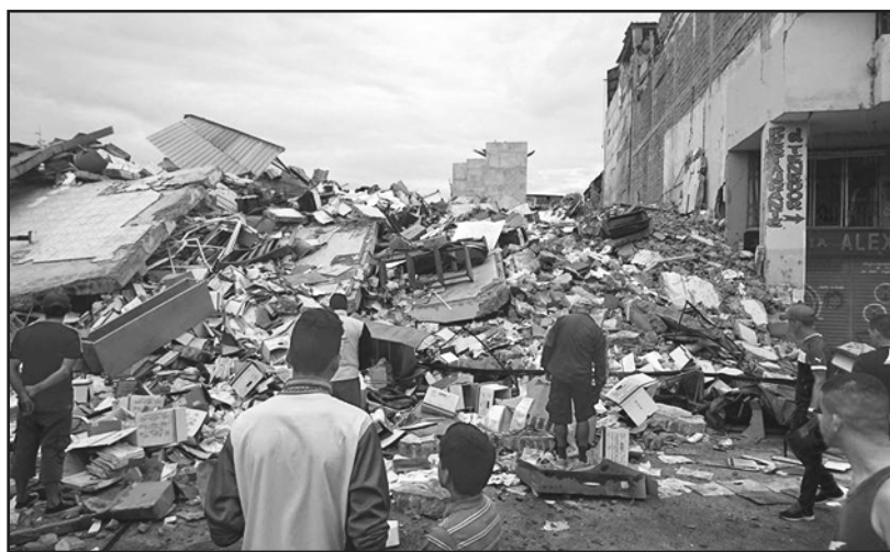
Foto capta el nivel de destrucción causado por el terremoto.
